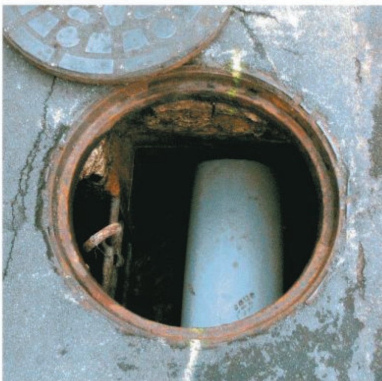
La gaine passe sans problème dans l'ancienne canalisation. Sa progression est suivie de regard en regard.
