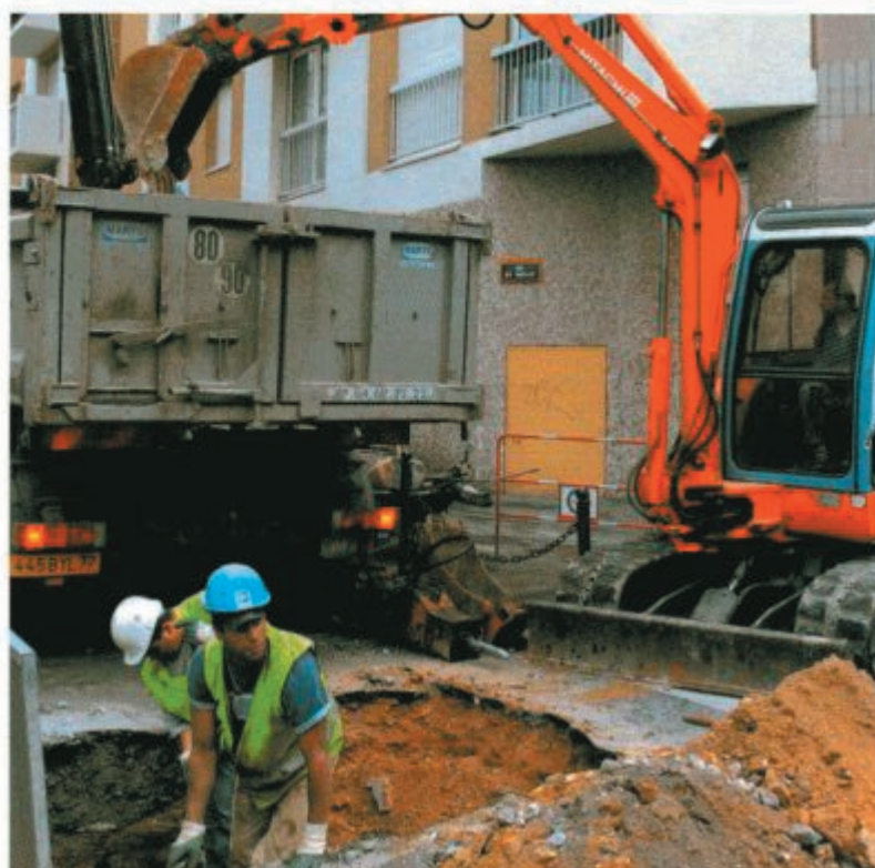
La reprise des branchements se fait de façon traditionnelle. C'est HP BTP qui se charge de cette opération.
