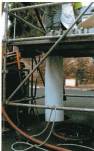
Les opérateurs de M3R guident la gaine lors de l'introduction dans le réseau. La réversion se fait à l'eau.
