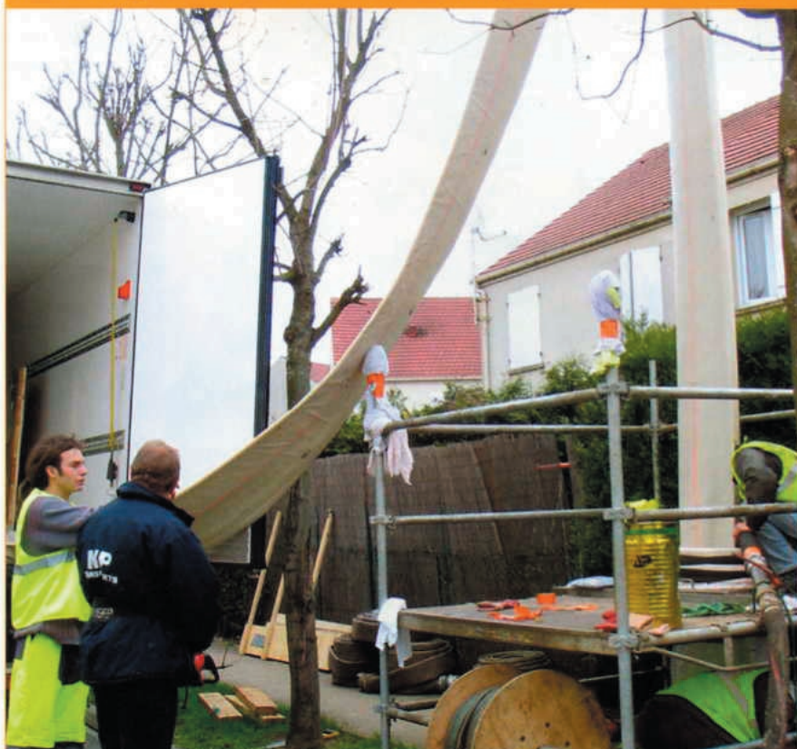
Le chemisage réalisé dans la canalisation d'eaux pluviales, Avenue de Bruyères
