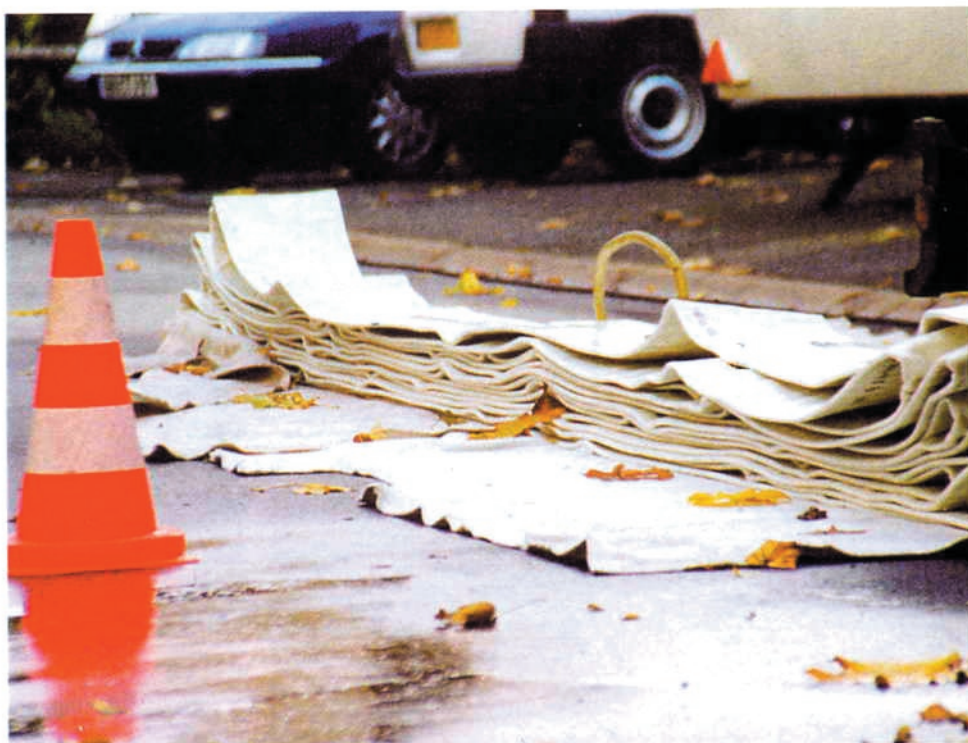
La gaine est sagement repliée à l'arrière du camion d'injection. Placée sous vide via une pompe à air, elle attend d'être entraînée dans le véhicule pour y être enduite de résine époxy.
