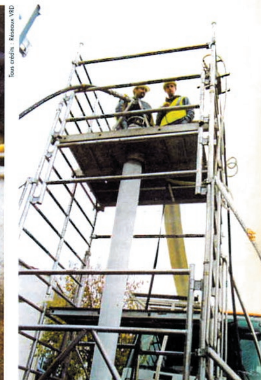
Un système d'entonnoir, situé en haut d'un échafaudage placé à l'aplomb du premier regard, permet aux hommes de M3R de passer la gaine préalablement enduite de résine époxy.
