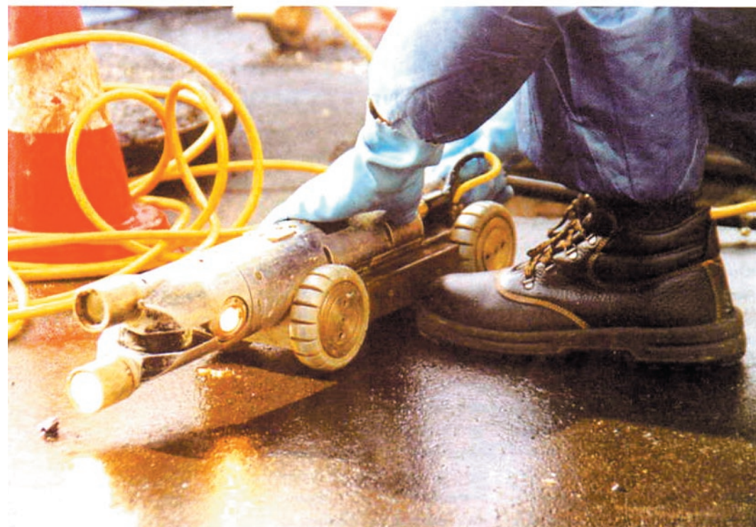
C'est avec un robot Rov Développement que M3R a effectué le travail d'auscultation des canalisations. Une deuxième vérification est effectuée le lendemain, peu avant le début des opérations.
