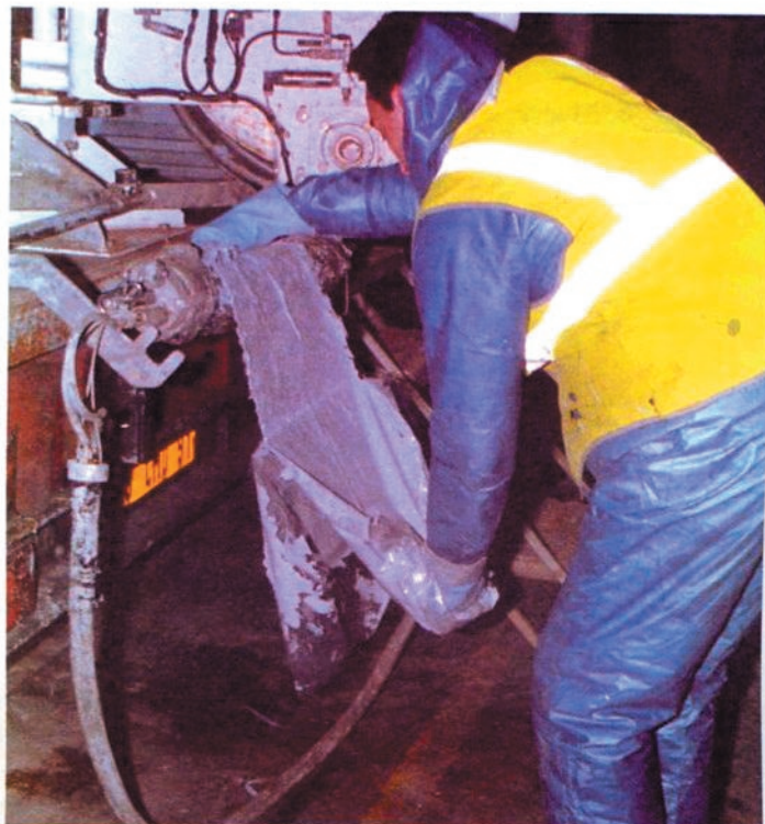
Le tissé enduit est enroulé autour du manchon. Celui-ci est relié au camion par un tube servant à acheminer l'air comprimé et l'électricité. Un câble en acier sert à tracter l'ensemble hors de la canalisation quand la pose de la manchette est achevée.
